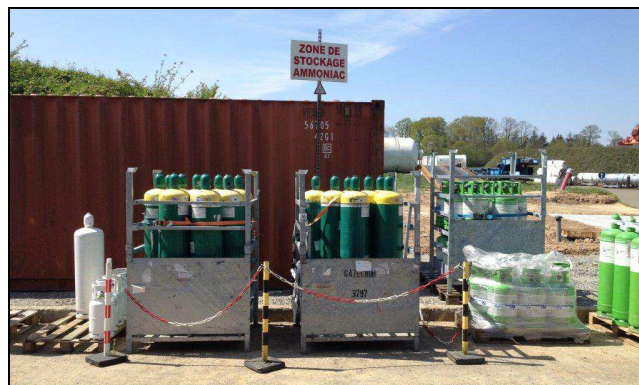
Aire délimitée de stockage des bouteilles d'ammoniac
